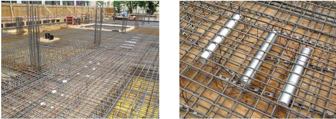
**Bild 7.** Übersicht über das Testgebiet in der Bauphase (links); Testfeld R1 mit 3 Rohren  $\varnothing$  87 mm, die in einen leeren und einen mit Mörtel gefüllten Abschnitt geteilt sind
